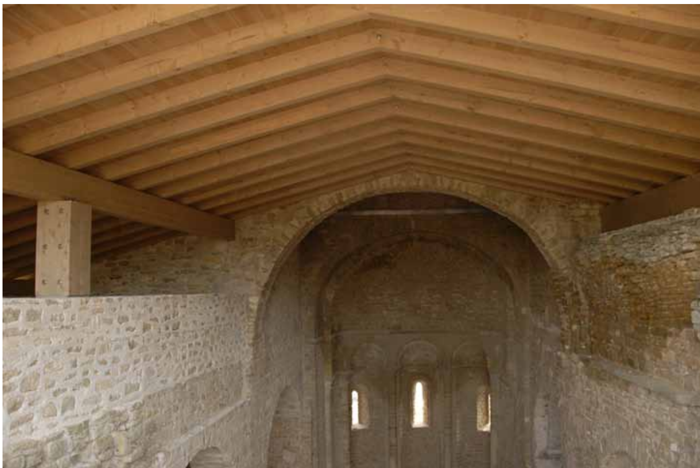
L'ESTRUCTURA LA COBERTA DE LA NAU CENTRAL ÉS DE BIGUES DE FUSTA LAMINADA D'AVET GL24
