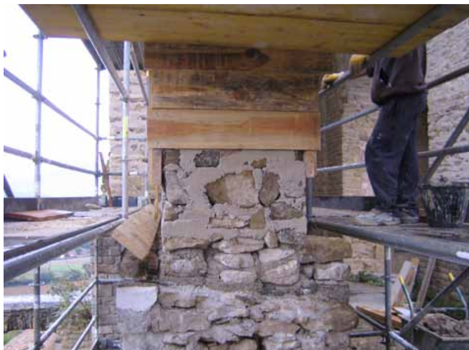
CONSTRUCCIÓ AMB SISTEMA TAPIAL DELS MURS
